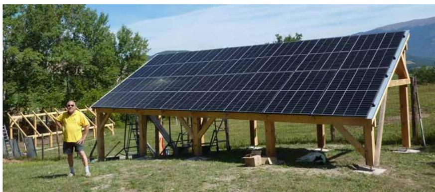
Grande installation chez Bernard Jay - route des Scées 32 panneaux sur structure bois type "car port", avec AutoConsommation et revente du surplus, et stockage sur batteries... ==> avec changement de voitures (électrique et hybride)
